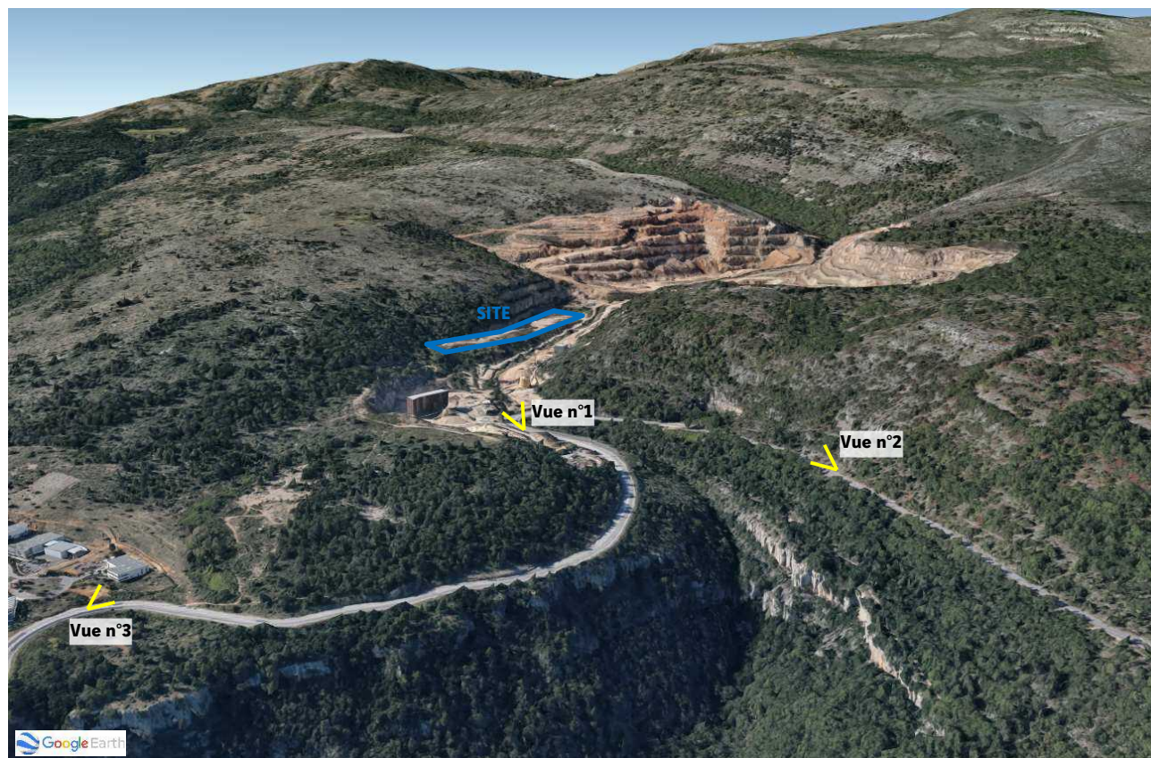
FIGURE 20 : VUE 3D DES ENVIRONS DU SITE DU PROJET, ET LOCALISATION DES PRISES DE VUE (SOURCE : EODD)
